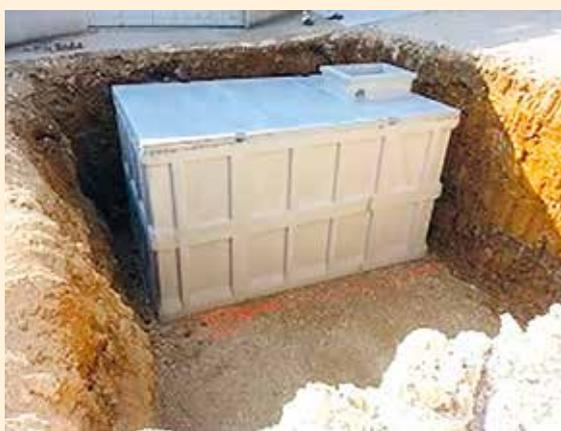
Stockao - Cuve béton 20 000 litres pour l'eau de pluie
