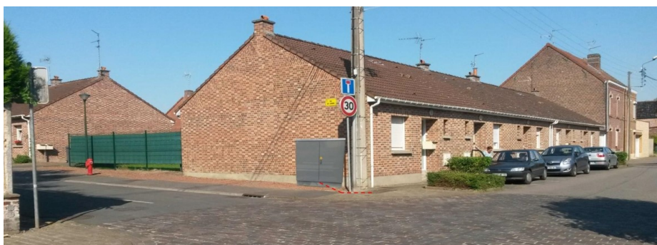
Implantation d'une armoire de répartition rue des Jardins
